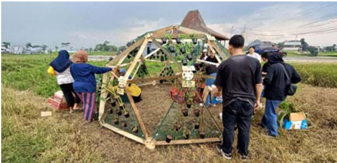
Gambar 7 Pemasangan Tanaman Herbal dan QR Code (Sumber: Dokumentasi Pribadi, 2025)
