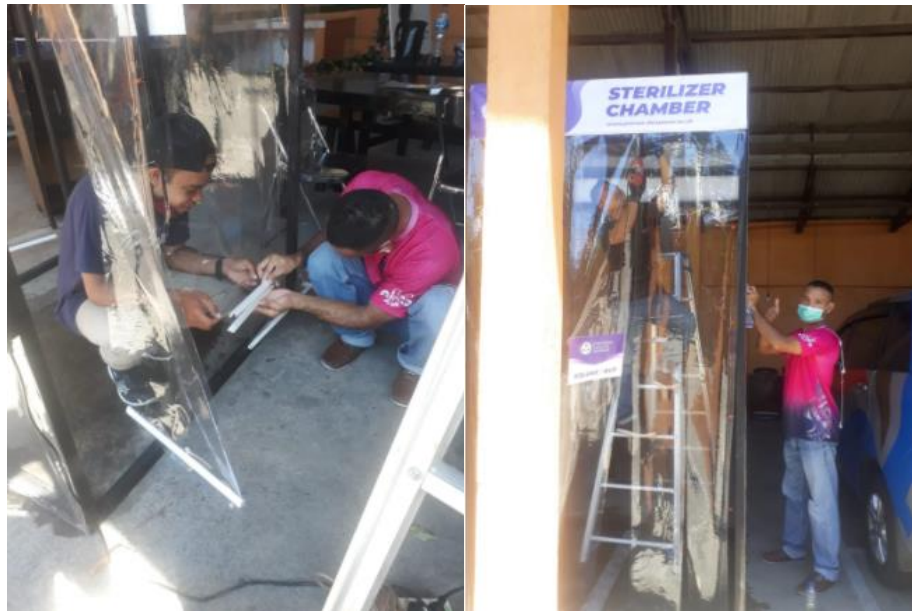
Gambar 3. 3 Proses pemasangan plastik tebal seperti tirai plastik pada bilik sterilizer chamber
