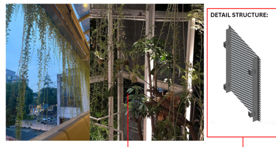
Gambar 7. Ventilasi Terbuka dan Penggunaan Metal Grid Panel pada Bangunan Jardin Café Sumber : Analisis Pribadi, 2025
