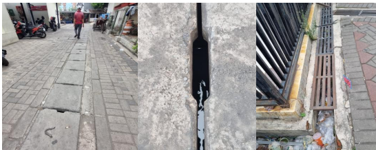
Gambar 3. Kondisi Selokan Tertutup dan Terbuka di Rusunawa Sombo yang Berisi Sampah Sumber: Dokumentasi Penulis, 2024
