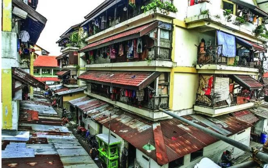
Gambar 1. Kondisi Fisik dan Kepadatan di Rusunawa Sombo Sumber: Arizaldi, 2019
