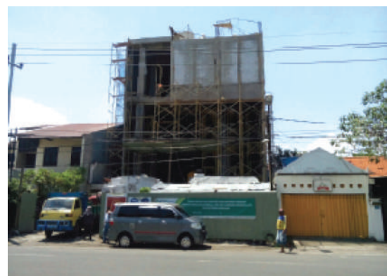
Gambar 6. Tampak Depan Bangunan (Dalam Tahap Pembangunan) Sumber: Data olahan pribadi, 2017
