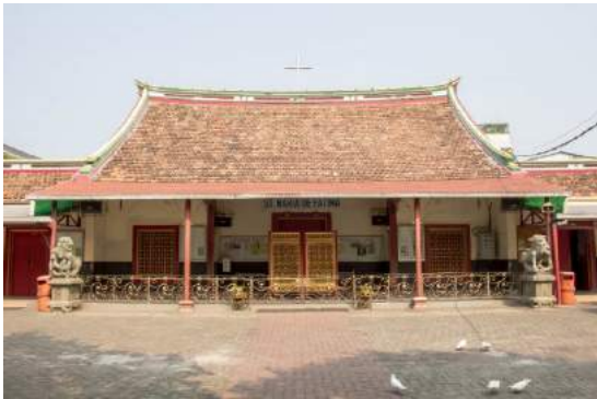
Gambar 4. Tampak depan bangunan rumah bangsawan keluarga Tjioe yang beralih fungsi menjadi Gereja Santa Maria de Fatima yang memiliki bentuk atap yanwei Sumber: Nicholas, 2015
