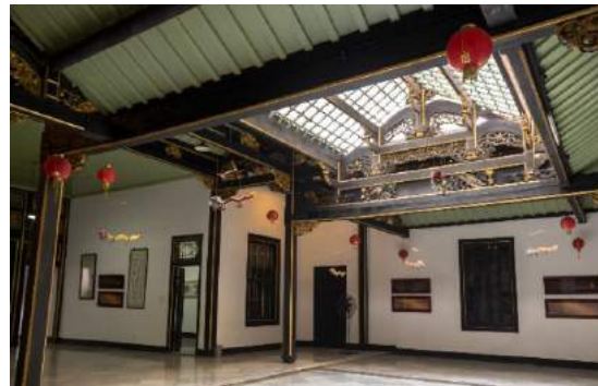
Gambar 8. Bagian inner courtyard pada bangunan Candra Naya yang tertutup, berfungsi untuk ventilasi masuknya pencahayaan alami ke dalam bangunan Sumber : Nicholas, 2016
